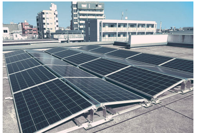
汐田総合病院の屋上に設置されたソーラーパネル
