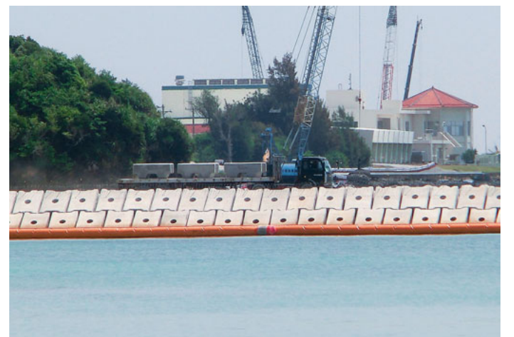
進む護岸工事(辺野古側) - 4月19日撮影 -
