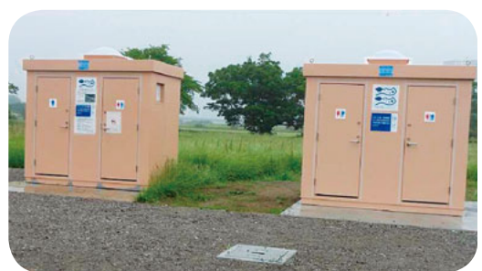
古市場グラウンドに設置された水洗トイレ
