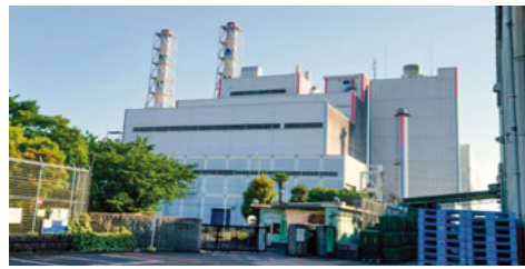
JR 東日本川崎火力発電所。JR 東海の新幹線にも電力供給しています。
