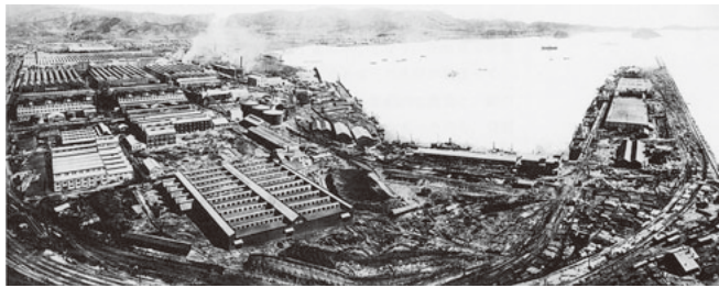
1927年に設立された世界最大規模の化学コンビナート興南工場(「日本窒素肥料事業大観」より)
