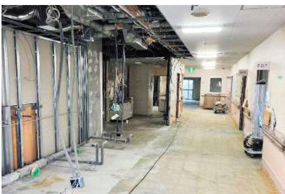
現在工事中の川崎協同病院、6階の病棟
